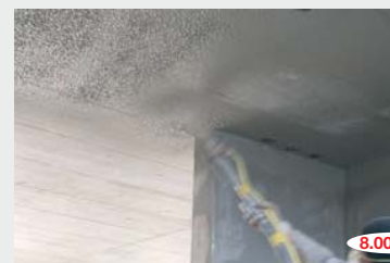
8.00 Uhr – KHF-it. wird ohne vorige Grundierung gespritzt.
