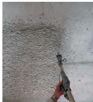
Spritzen einer Betondecke
